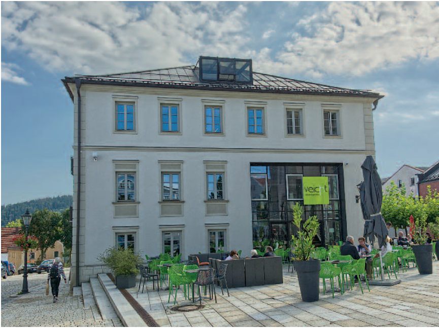
Das Gebäude des ehemaligen Gasthofes Veicht wurde in Kooperation von Stadtverwaltung und privaten Investoren saniert und revitalisiert. Einen wichtigen Beitrag zur Konzeptentwicklung leistete die Städtebauförderungsabteilung an der Regierung von Niederbayern.
